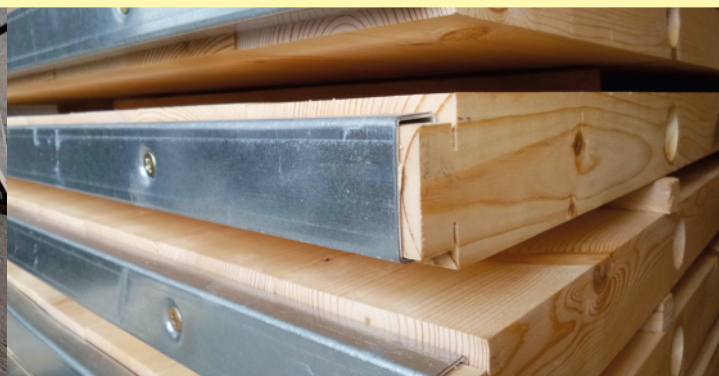
Deski klejone i skręcane trzema śrubami wraz ze sprężynami kompensującymi
