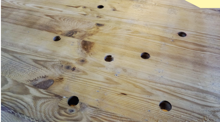
Wycinanie uszkodzeń i wklejanie korków
